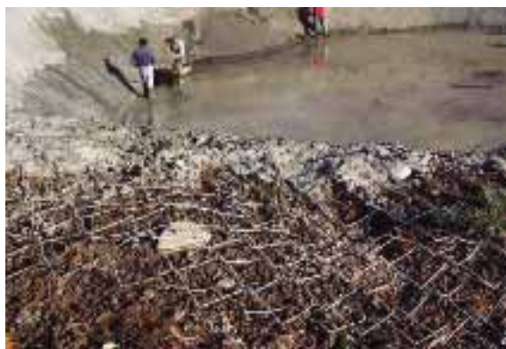
Foto 4.10. Sistema de sellado con mallas y cemento estucado.
