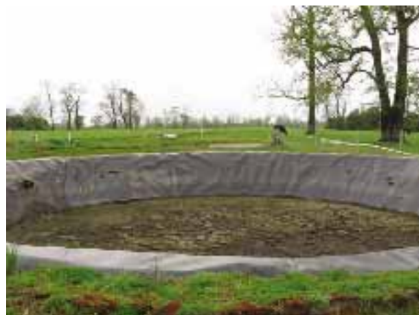
Foto 4.12. Pozo purinero sellado con poliestireno de alta densidad.
