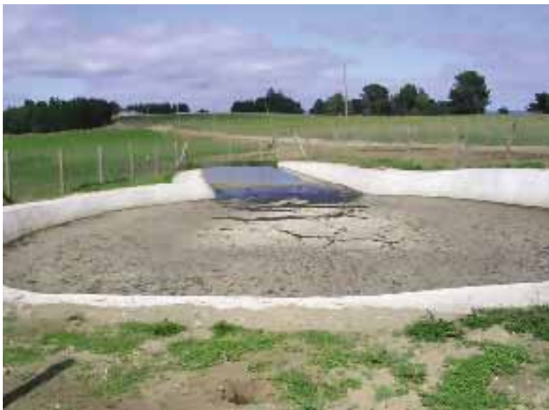
Foto 4.5. Pozo de hormigón con malla metálica para almacenamiento de purin.
