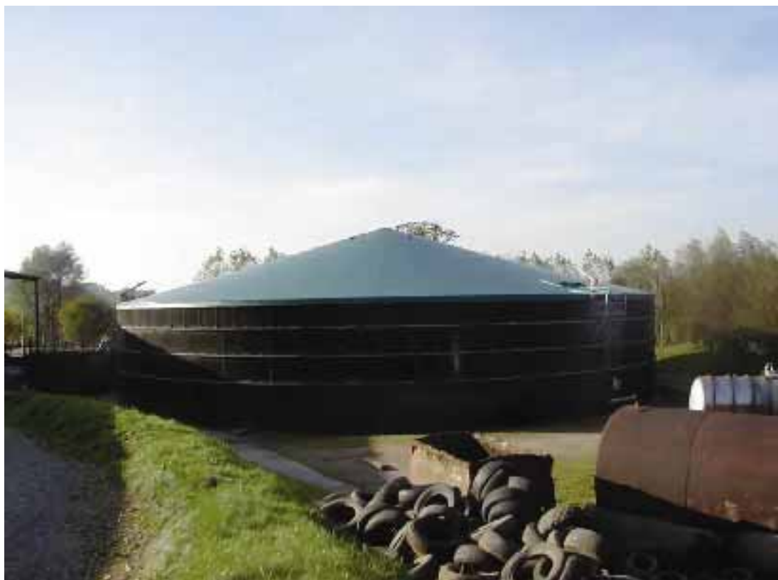
Foto 4.13. Pozo de acero y techado.
