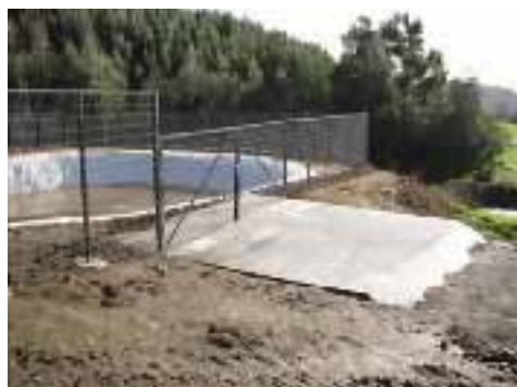
Foto 4.4. Rampa de acceso y cercado de pozo purinero.
