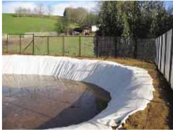
Foto 4.11. Pozo sellado con PVC.
