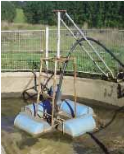
Foto 5.10. Bomba eléctrica montada sobre balsa flotante y revolvedor.
