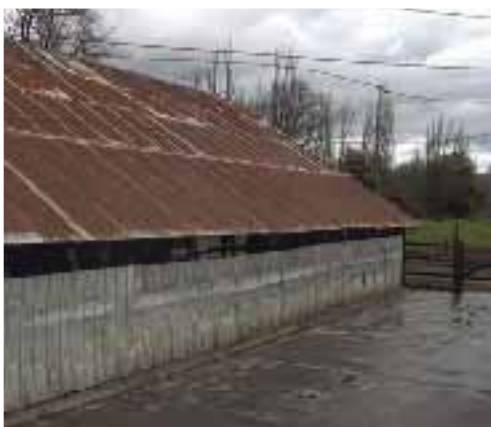
Foto 1.3. Techos sin canalización independiente de aguas lluvia.
