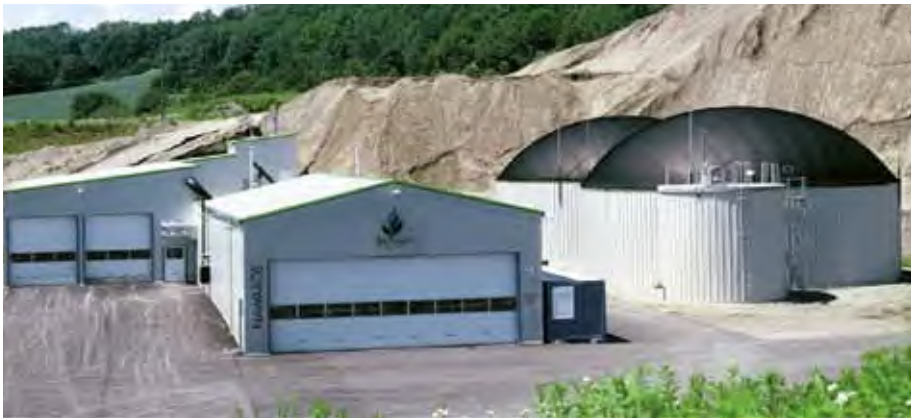
Figura 3: Planta de biogás
