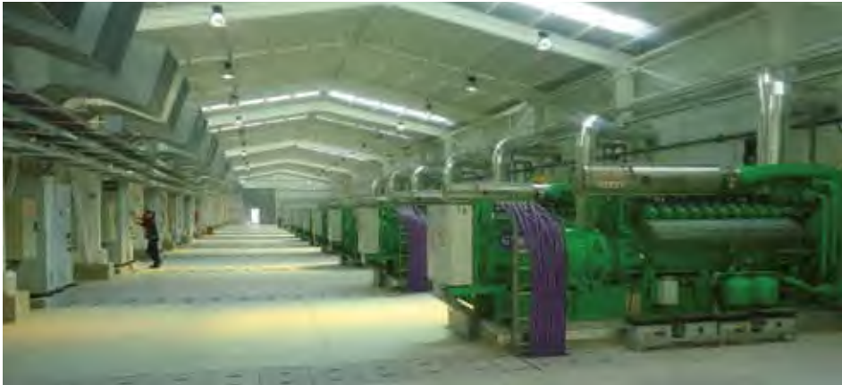
Figura 29: Grupos generadores: en contenedor y en casa de máquinas
