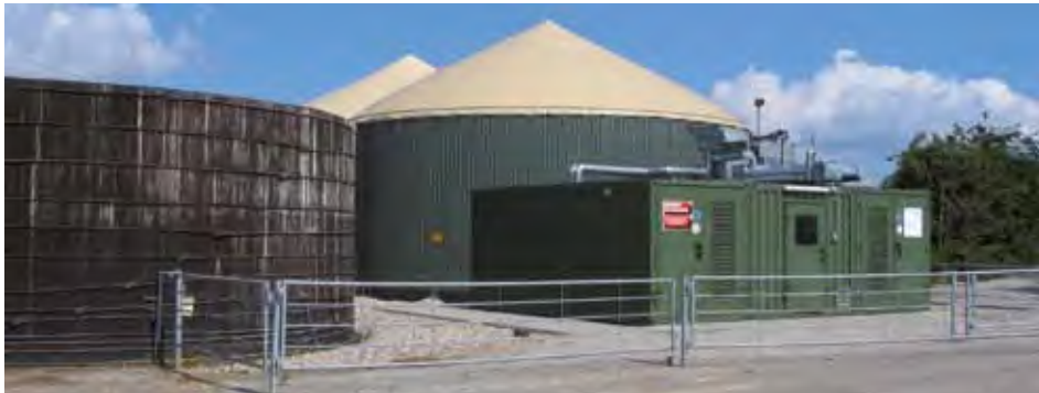
Figura 9: Planta de biogás
